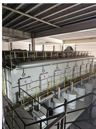
依托现有喷漆废气处理措施
