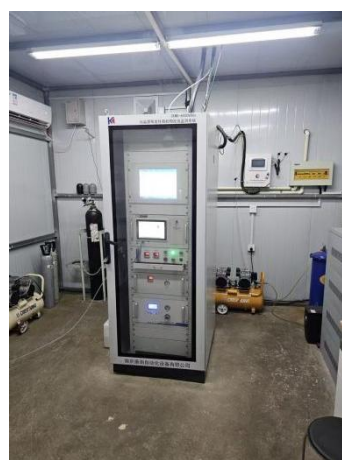
现有喷漆废气在线监测
