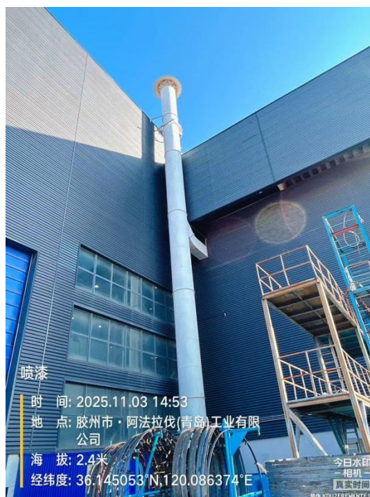
依托现有喷漆废气排气筒 DA010
