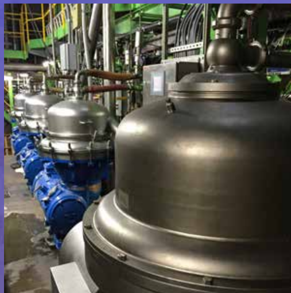
Этот сепаратор-отделитель Альфа Лаваль позволил Westward Seafoods уменьшить содержание жира в клеевой воде до менее чем 0,5 %.
