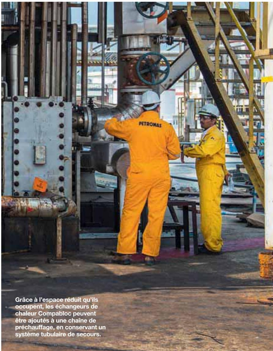
Grâce à l'espace réduit qu'ils occupent, les échangeurs de chaleur Compabloc peuvent être ajoutés à une chaîne de préchauffage, en conservant un système tubulaire de secours.
