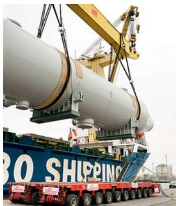
**Погрузка кожухотрубного теплообменника Olmi.**
